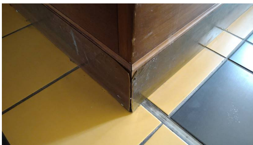
Stávající stav – okopový plech – typické poškození
