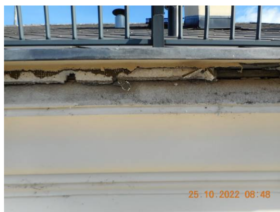
Poškození čela římsy – trakt C
