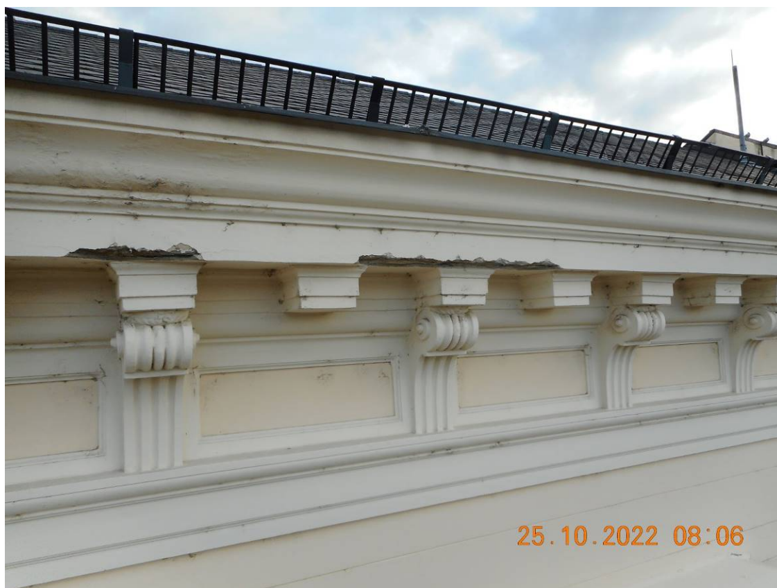
Lokální poškození spodní části římsy – trakt D
