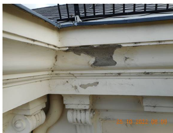
Lokální poškození spodní části římsy – trakt D
