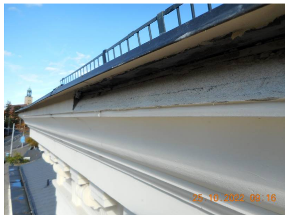
Poškození čela římsy – trakt C
