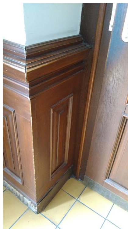
Stávající stav – poškození obkladu
