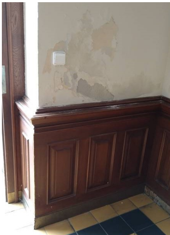
Stávající stav – foto vlhkého zdiva m.č.122
